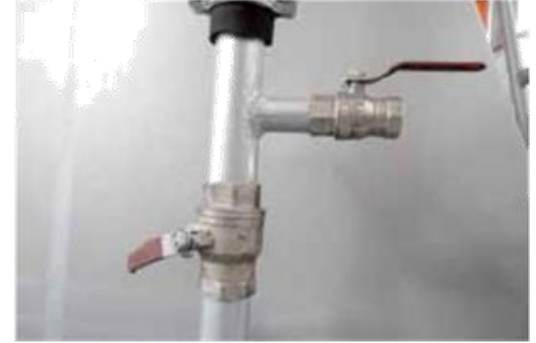
9- Tankın içindeki havayı boşaltma ve ikinci boşaltım valfi. Üstteki valf havayı boşaltır. Alttaki ise diğeri boşaltım valfi.
